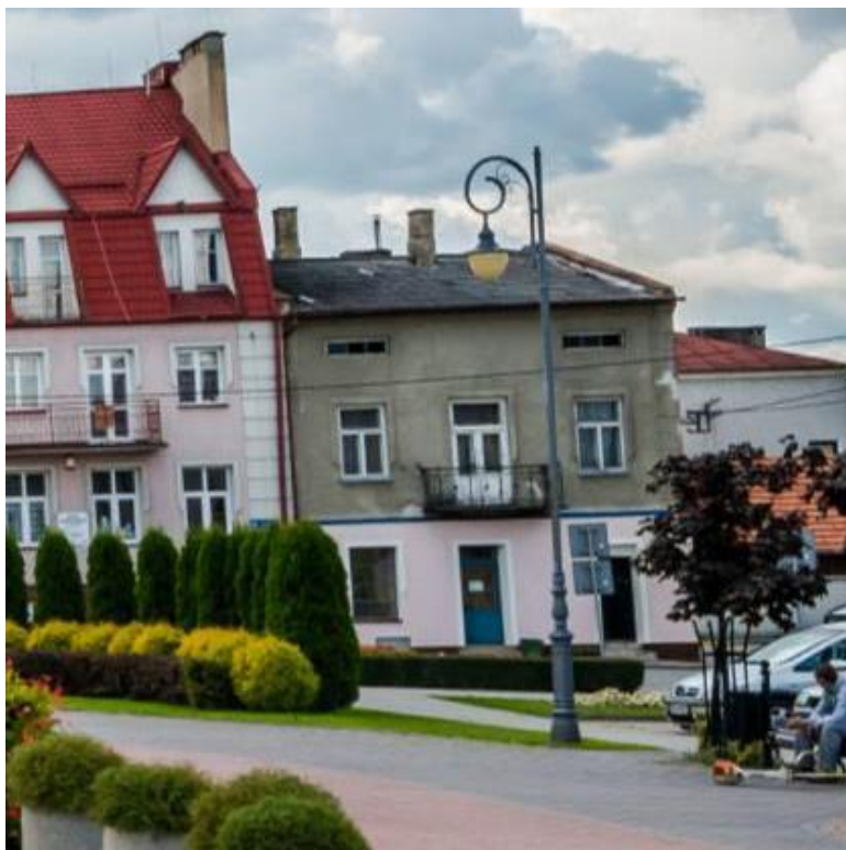
Fot. 13 Jednopiętrowa, trzyosiowa kamieniczka znajdująca się w części zachodniej pierzei południowej.
